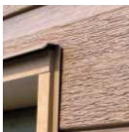
3. Larmier : fait office de jet d'eau au-dessus des fenêtres et des portes.
